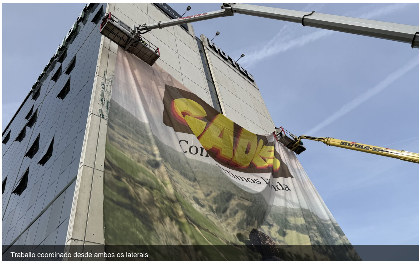
Inicio do izado · fixación na parte superior da fachada
